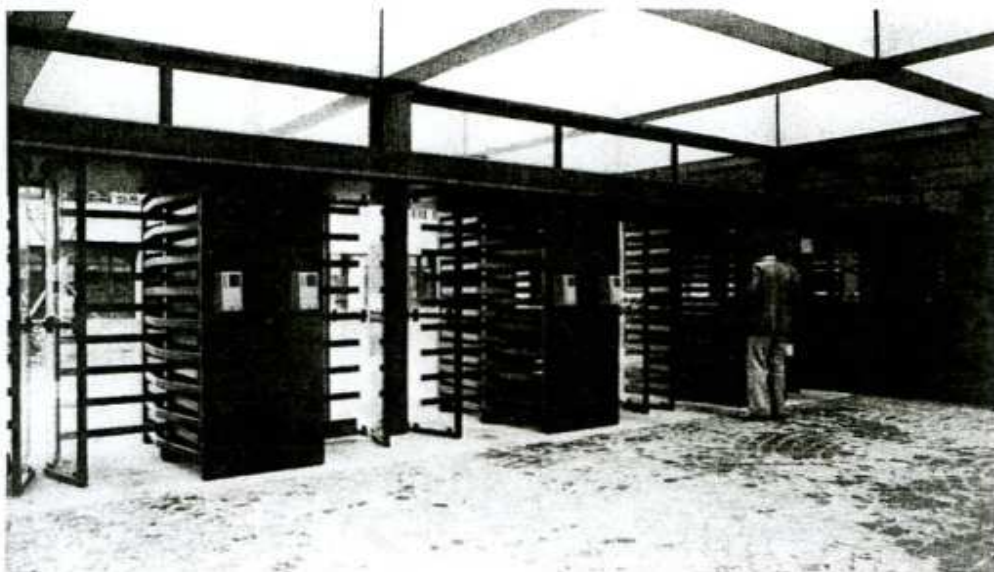
Bild 15 Überwachte Eingangszone zu einem Verwaltungsgebäude der Schweizerischen Eidgenossenschaft. Die Drehtüren werden erst freigegeben, wenn über die Leser ID 2000 eine Zutrittsberechtigung festgestellt worden ist.
