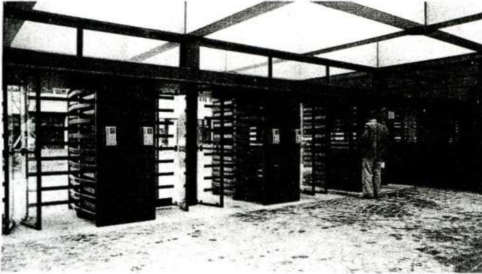
Fig. 15 Zone d'entrée surveillée pour un bâtiment d'administration de la Confédération Suisse. Les portes tournantes seront ouvert au moment que les lecteurs ID 2000 ont constatés l'autorisation pour entrer.
